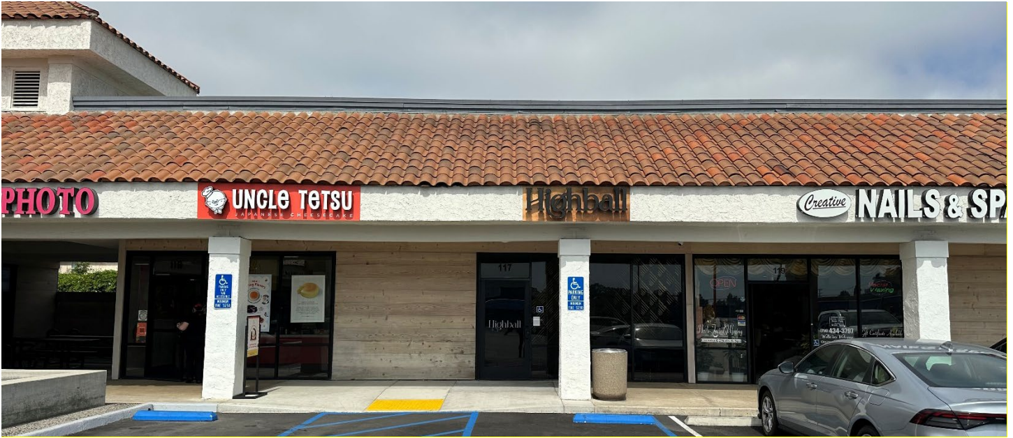
1. Existing tenant frontage - front entrance
